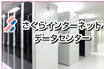
都市型データセンター
